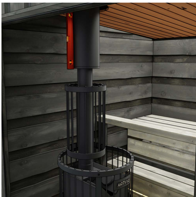
12. Kontrollera att skorstenen är rak. Flytta bastuaggregatet vid behov.
