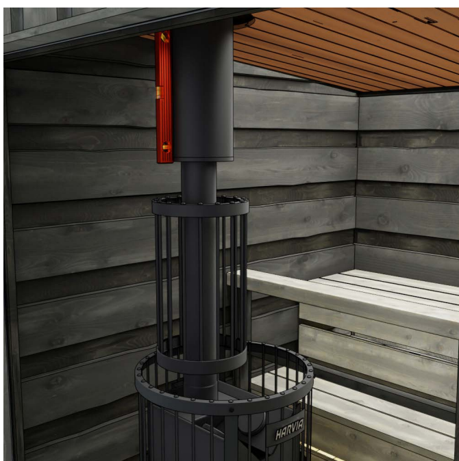
12. Controleer of de schoorsteen mooi recht staat. Verplaats indien nodig de kachel.
